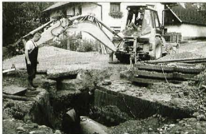
V Zgornjih Dupljah so že obnovili vodovodno omrežje, sedaj pa gradijo kanalizacijo.
